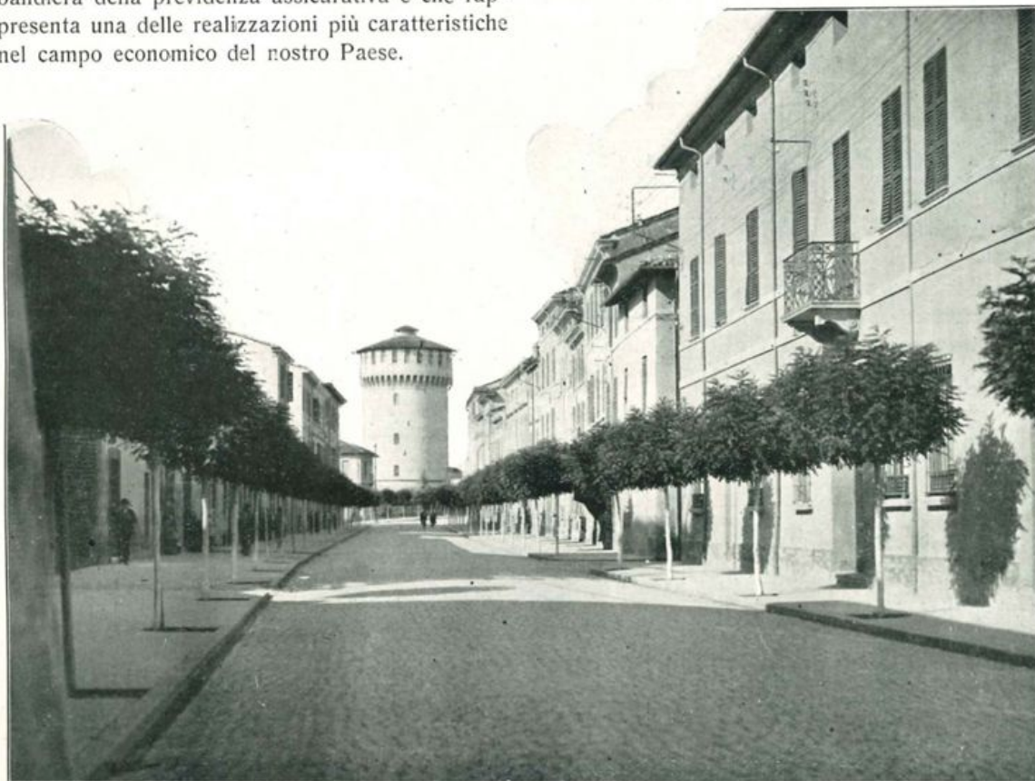
Opere pubbliche. - La pavimentazione del Corso Diaz a Forlì.
