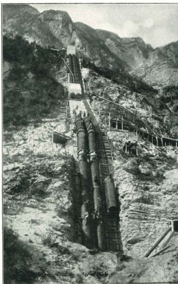
L'impianto del Tonale (Rovereto). (Centrale di Riva. Montaggio della tubazione).
