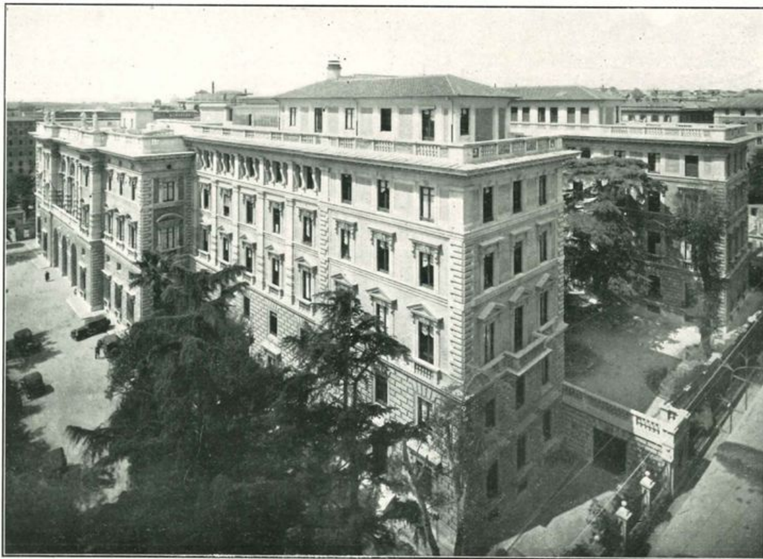
Una visione completa del Palazzo dell'Istituto.
