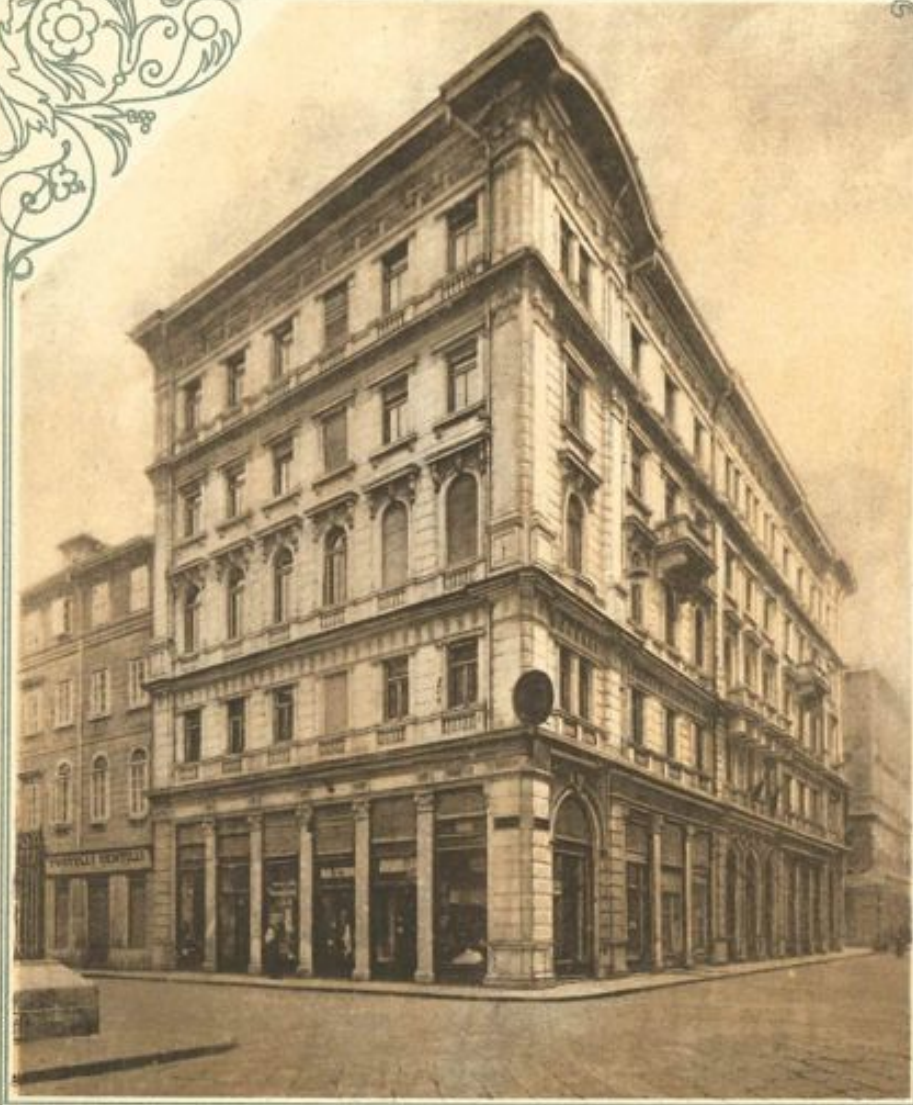
TRIESTE: via S. Spiridione (lato sinistro).
