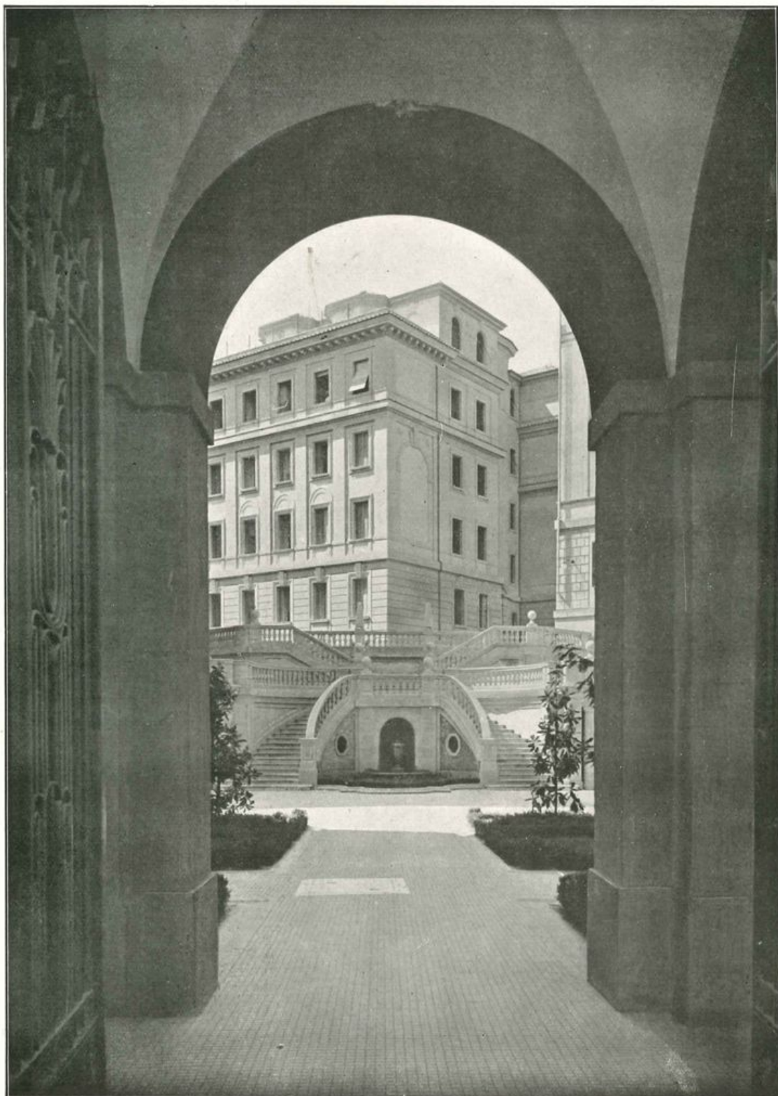
ROMA - GRUPPO DI 7 EDIFICI AL VIALE MARTIRI FASCISTI (PARTICOLARE) ROME - GROUP OF 7 BUILDING IN VIALE MARTIRI FASCISTI (DETAIL)
