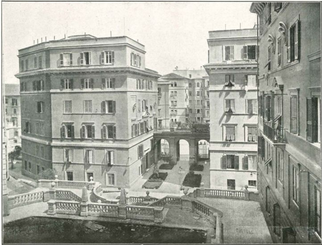
ROMA - GRUPPO DI EDIFICI AL VIALE MARTIRI FASCISTI ROME - GROUP OF BUILDINGS IN VIALE MARTIRI FASCISTI
