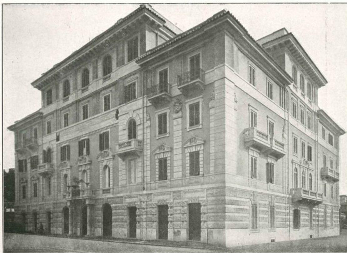
ROMA - EDIFICIO IN VIALE GORIZIA ROME - BUILDING IN VIALE GORIZIA
