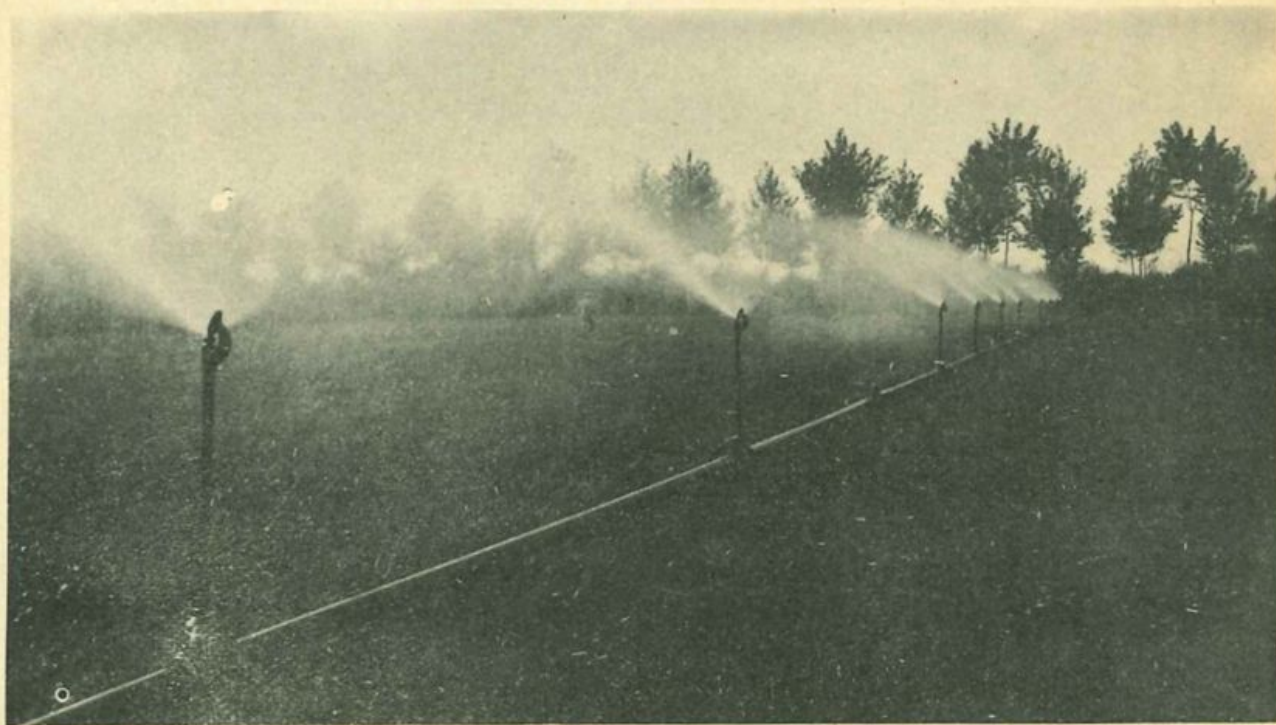
Istituto Sperimentale di Modena — Veduta di un'ala piovente, in funzione, dall'impianto a pioggia — da servire per tutto il podere — interamente a gazogeno, con carbone prodotto nell'Azienda.
