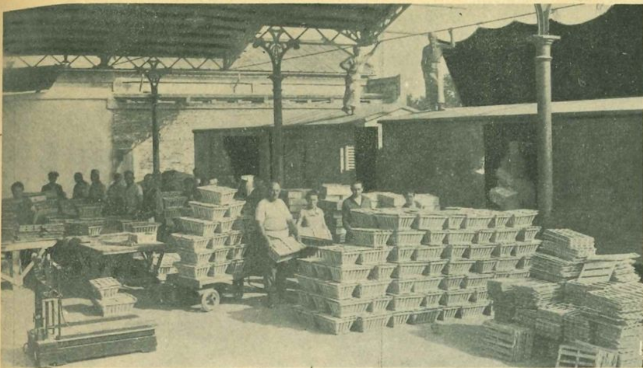
Consorzio agrario cooperativo di Imola - Sezione ortofrutticola - Caricamento delle pesche su vagoni aerati.
