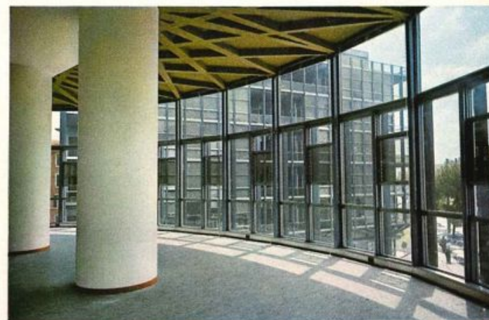
Palazzina C: particolare di una delle sale ellittiche. Vi si possono svolgere riunioni e incontri di lavoro.
