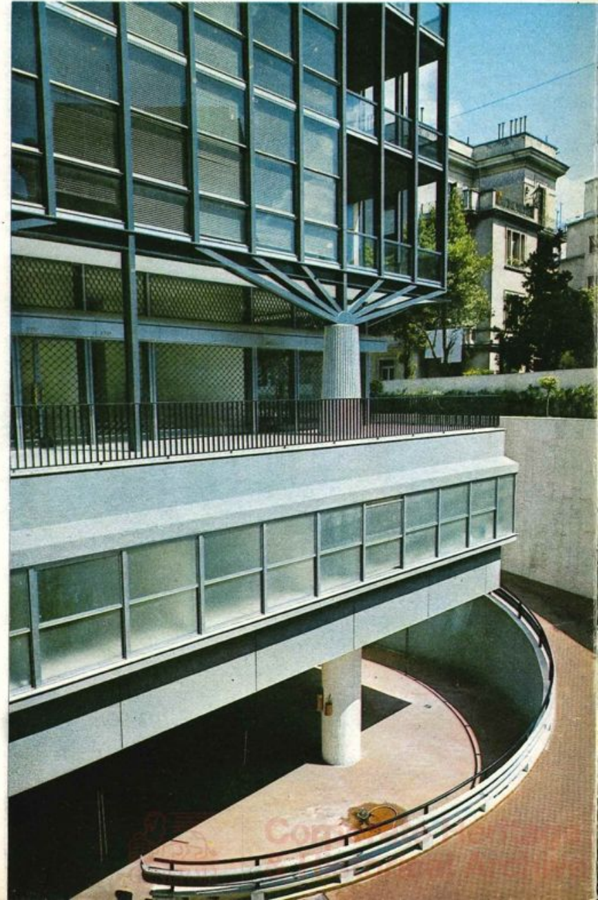
Particolare della palazzina A, con la sottostante rampa di accesso all'autorimessa.
