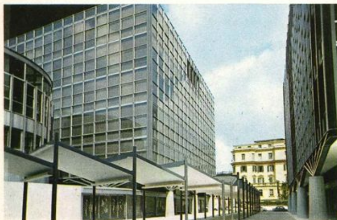
Il passaggio fra le palazzine, con la sovrastante pensilina: una utile protezione nei giorni di pioggia.
