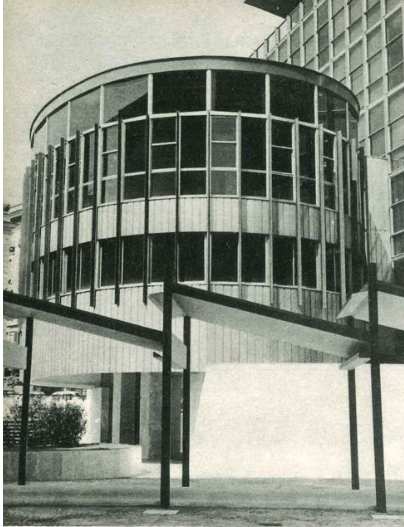
Prospetto del « corpo ellittico » annesso alla palazzina C. In primo piano, la pensilina sovrastante il passaggio pedonale.
