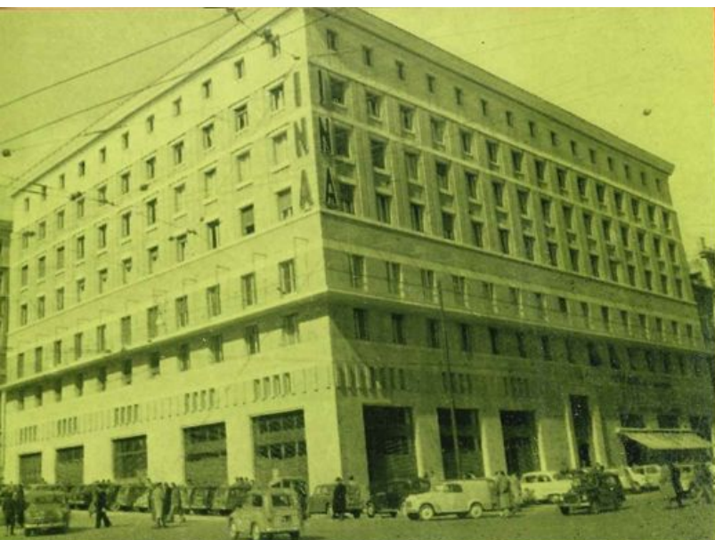
NAPOLI - Il nuovo fabbricato di Piazza Municipio, adiacente all'analogo palazzo della Banca d'Italia
