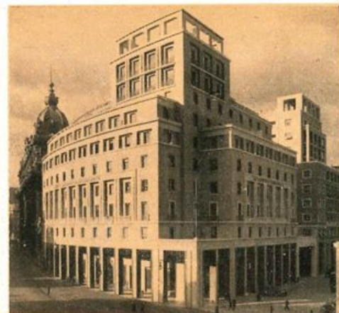
GENOVA - Il complesso edilizio in Piazza Colombo
