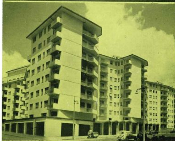
ROMA - Le palazzine signorili in Via Marangoni e i nuovi edifici in Via Somalia
