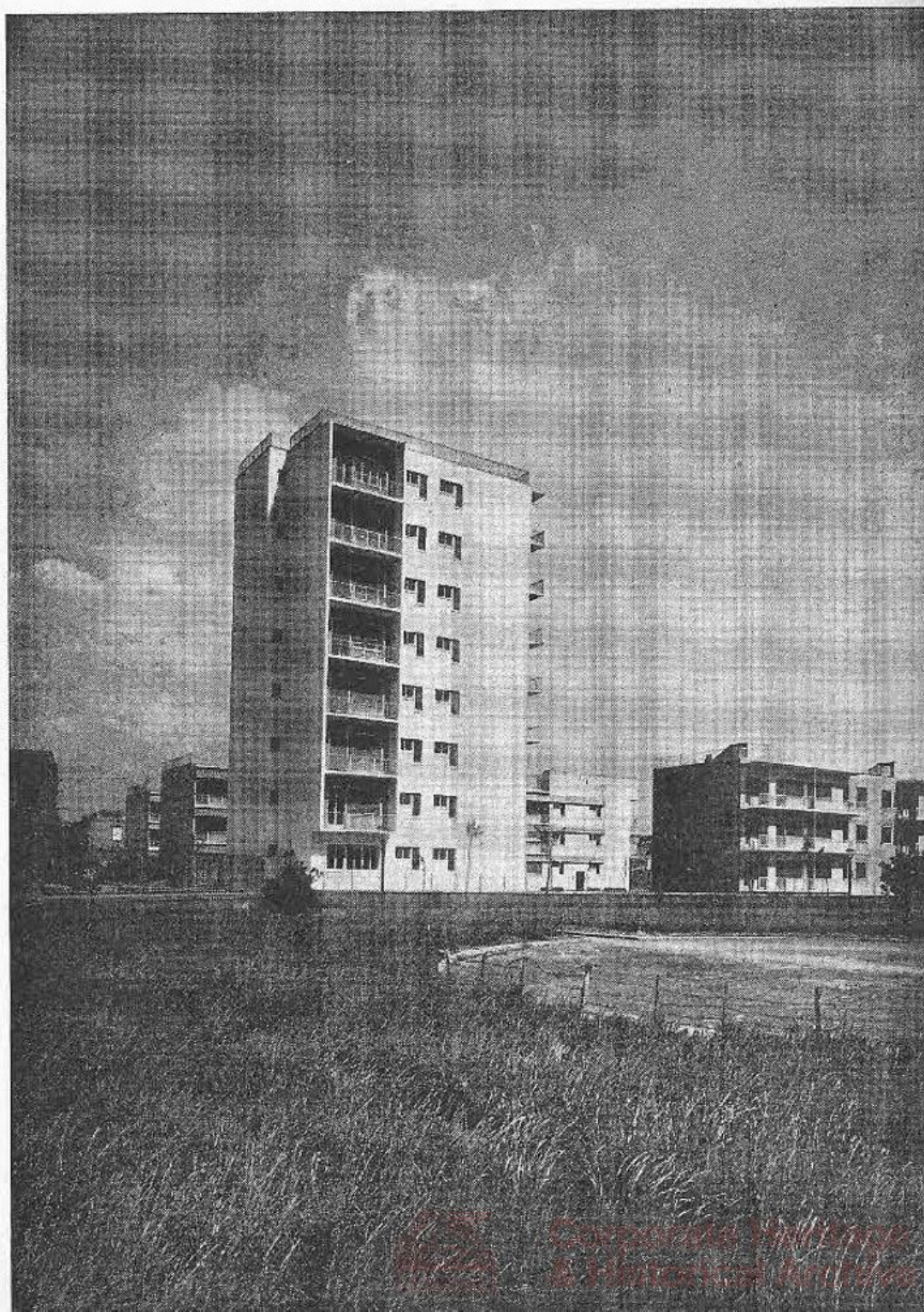
Fig. 12. - Una casa torre del quartiere di Barra.
