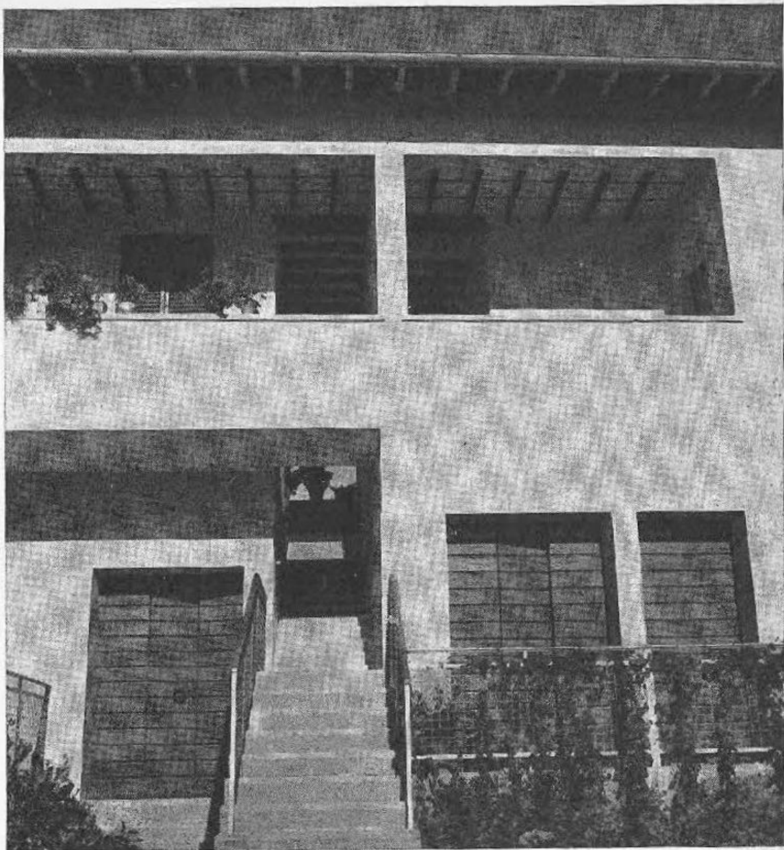
Fig. 22. - Particolare della facciata.
