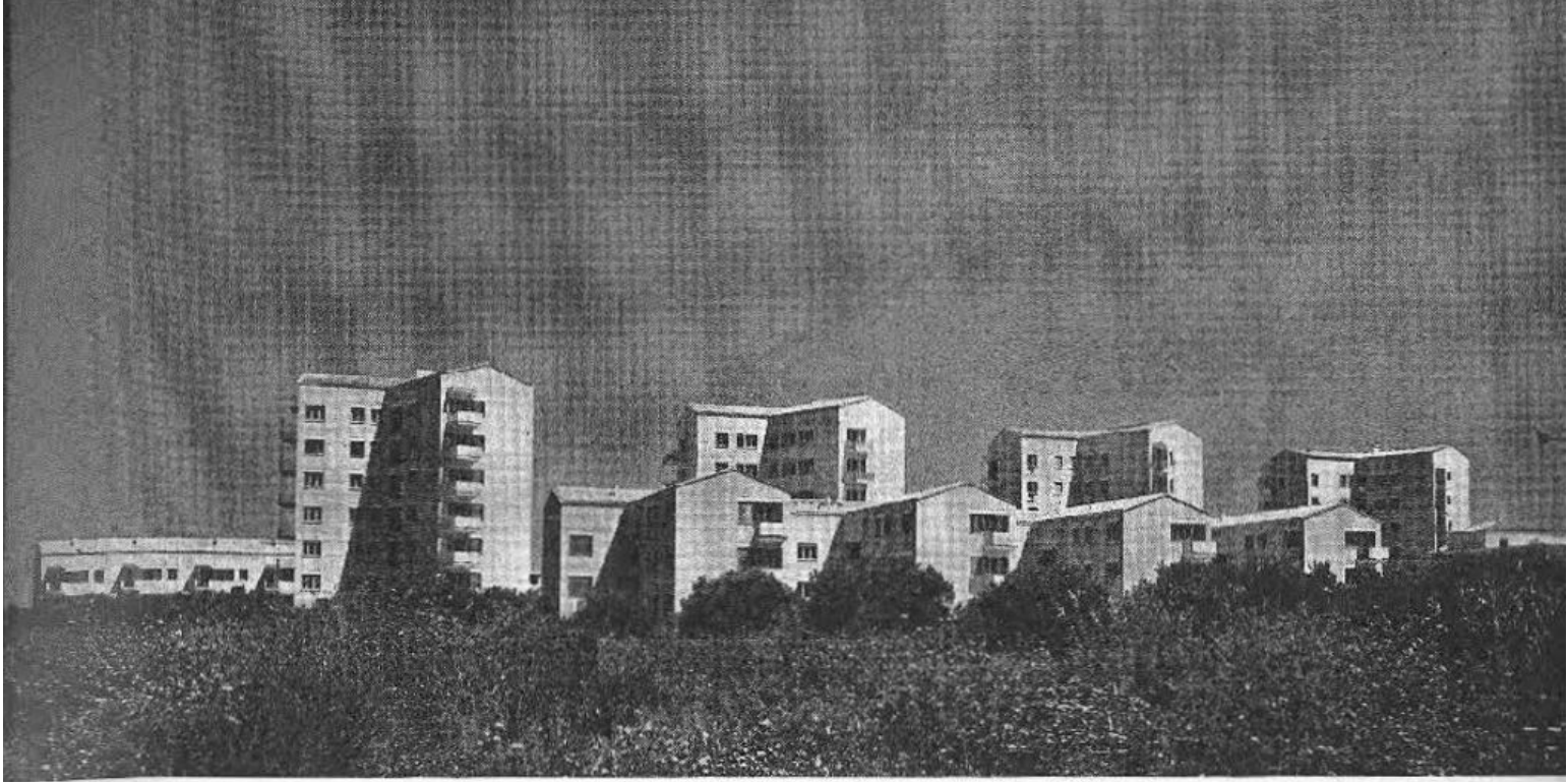
Fig. 3. - Veduta del quartiere dall'autostrada Roma-Ostia.
