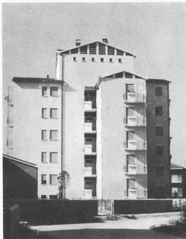
1. Planimetria generale - 2. Veduta della casa stellare - 3. Pianta piano tipo e prospetto della casa stellare - 4. Altra veduta della casa stellare - 5. Pianta e prospetti delle schiere - 6. Veduta parziale della unità.
