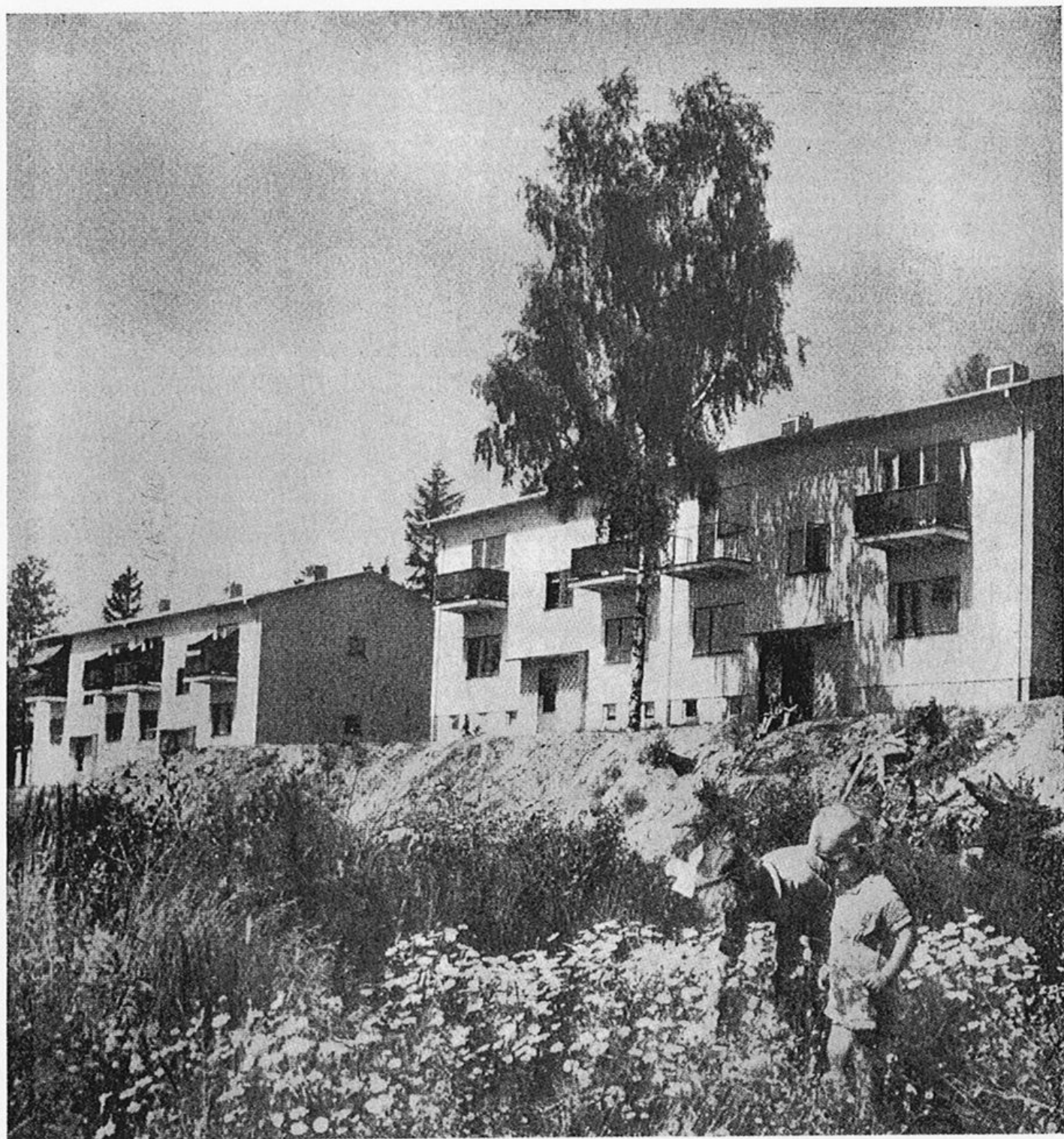
Fig. 23. — Goteborg. Gruppo edilizio di Kungsladugard. Arch. C. F. Ahlberg.
