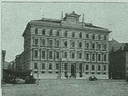
Trieste, Via della Stazione N. 888-1.
