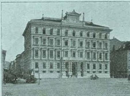
Trieste, Via della Stazione N. 888—1.
