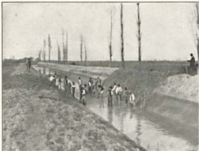
Nuovo canale in costruzione (1921).
