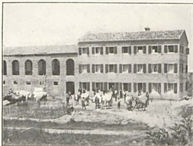
Colonica Cà-Doretto in corso di costruzione, 1923.
