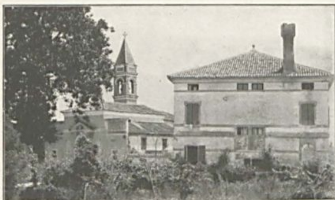
Chiesa di Cà-Cottoni e fabbricato delle scuole.
