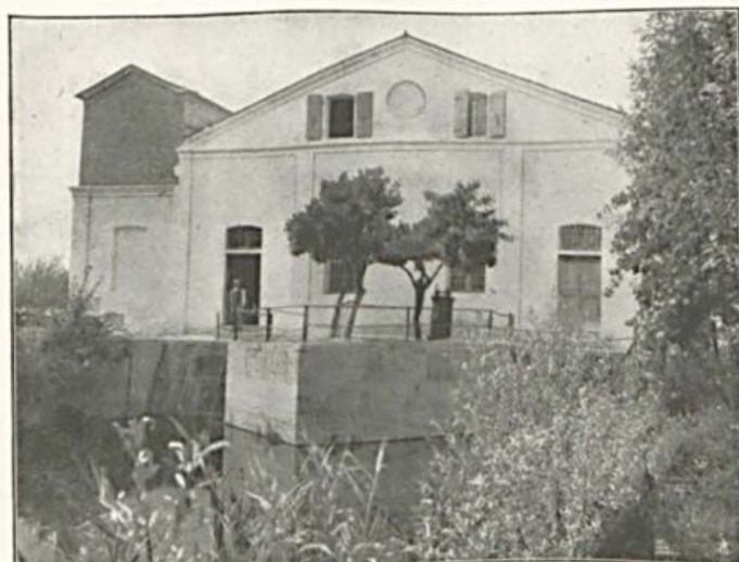
Idrovora. - Bacino di presa.
