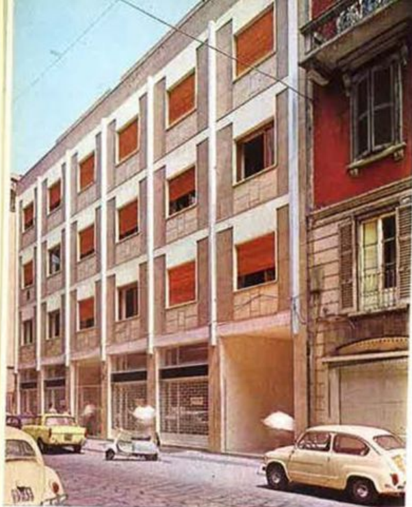
MILANO, Via Solferino - Via San Marco. Prospetto sulla Via San Marco del corpo destinato ad abitazioni.
