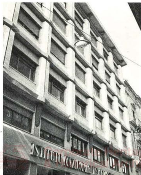
CALTANISSETTA, Corso Vittorio Emanuele - La nuova costruzione, sorta nel cuore della città, su progettazione del Prof. Arch. Vittorio Ziino, si compone di un piano terreno destinato a negozi e di quattro piani sovrastanti, destinati ad uffici e civile abitazione. Al primo piano è stata insediata l'Agenzia Generale dell'INA.
