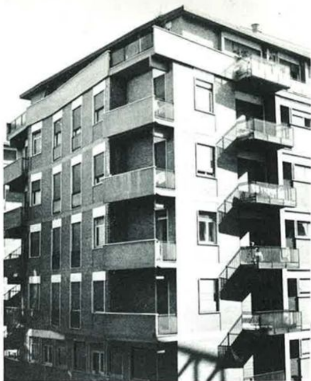
ROMA. - Una delle cinque palazzine del complesso edilizio dell'I.N.A., che è sorto nella zona tra le vie Cassia vecchia e Cassia nuova, nelle immediate vicinanze della zona residenziale di Vigna Clara.
