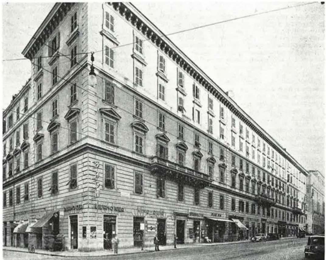
Il grande stabile di proprietà dell'I.N.A. a Roma, in via Po angolo via Tirso. Pur risalendo la sua costruzione ad oltre 50 anni, si presenta in ottimo stato di conservazione. Nonostante il blocco degli affitti, le grandi società e gli Enti hanno sempre potuto eseguire i necessari lavori di manutenzione, cosa che non è stata possibile ai privati, con grave danno del patrimonio immobiliare
