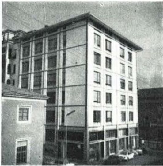
Il nuovo edificio costruito dallo I.N.A. in Aosta occupa una superficie di mq. 360,88 ed ha un volume di circa 8.252 mc. Esso è situato in una posizione centralissima, all'incrocio delle due principali arterie di transito e di penetrazione della città
