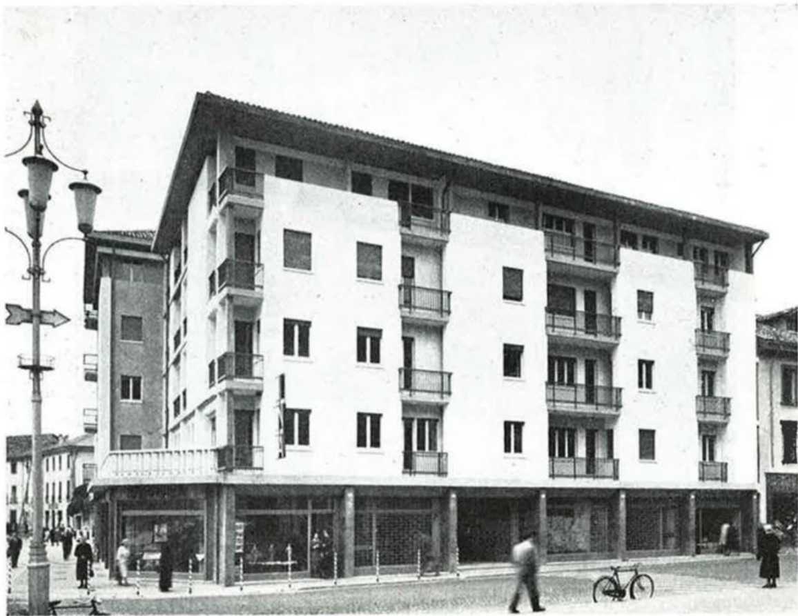
Belluno: La facciata su via Matteotti del nuovo edificio dell'INA, che è situato su una linea di traffico tra le più importanti della città, linea che collega il vecchio centro cittadino alla stazione ferroviaria e a quella delle corriere. L'immobile costituito da un cantinato, un piano terra e quattro piani copre un'area di circa 406 mq.
