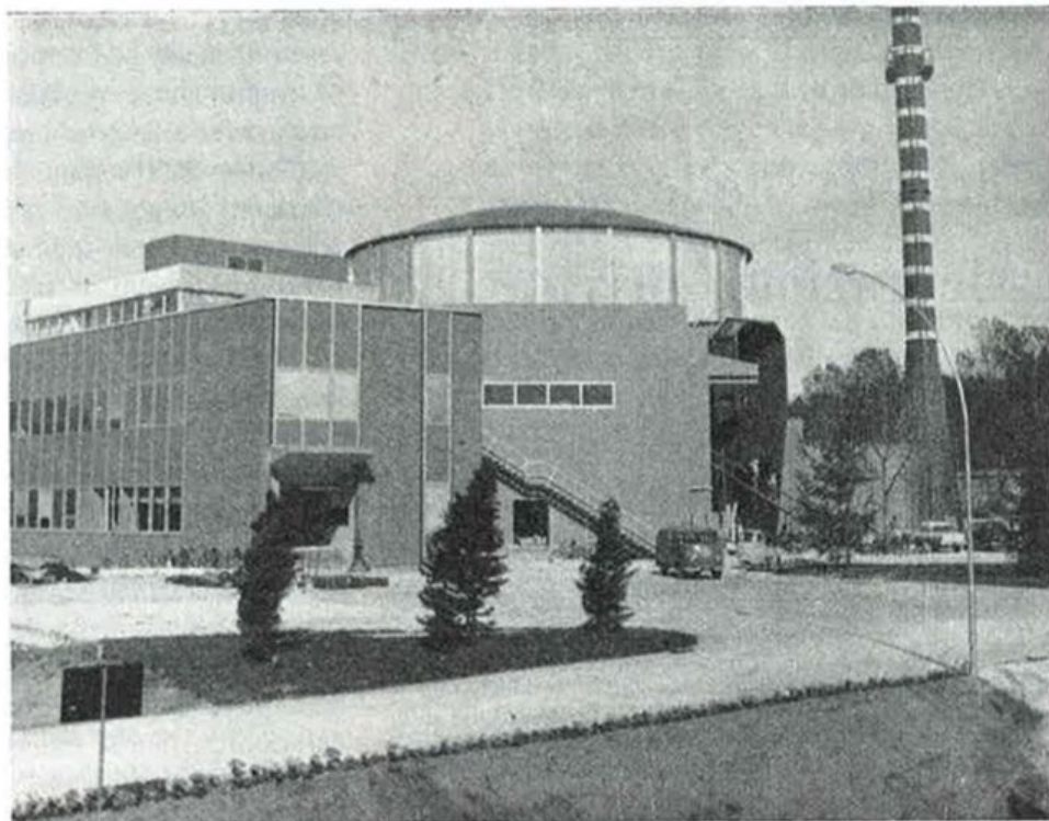
Ispra - Edificio del reattore Ispra I con annessa ciminiera
