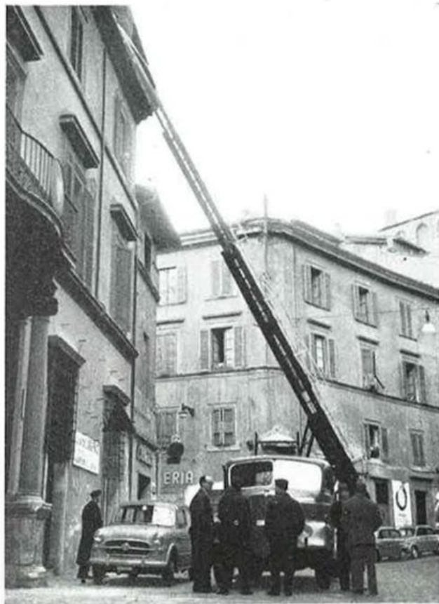
Un cornicione pericolante: quale più evidente immagine delle responsabilità che incombono ai proprietari di fabbricati? Unica tutela contro i risarcimenti che essi dovessero pagare per danni a persone ed a cose è una polizza di responsabilità civile verso terzi «Proprietari di fabbricati», quale l'Assitalia ha predisposto
