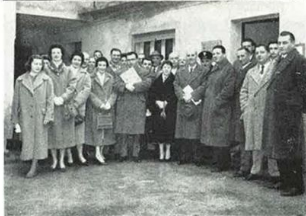
In alto: CUNEO - L'Arcivescovo di Cuneo, mons. Guido Tonetti, benedice il costruendo edificio per i dipendenti dell'Agenzia dell'I.N.A. A sinistra, dall'alto: CUNEO - Un momento della riunione dell'organizzazione dell'Agenzia Generale; in basso: TREVISO - I partecipanti alla inaugurazione dell'Agenzia locale di Roncade
