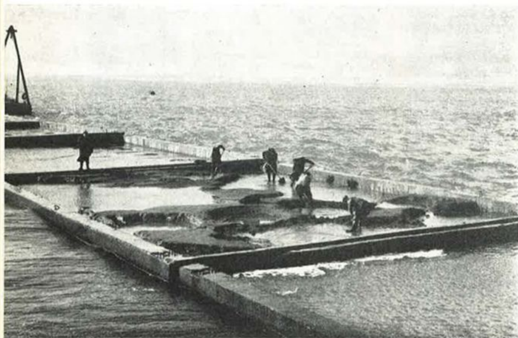
GENOVA - Alcuni cassoni in opera per la costruzione della diga foranea che si ostenderà, parallelamente alla costa, per una lunghezza di 2.800 metri con il compito di proteggere il terrapieno, che avrà oltre 100 ettari di estensione. Il corpo principale della diga, costituito da 58 grandi cassoni in cemento armato riempiti di sabbia, poggia su di un imbasamento subacqueo; sovrastante ai cassoni, un muro di sovrastruttura, alto cinque metri sopra il livello del mare, servirà ad arrestarne il moto ondoso
