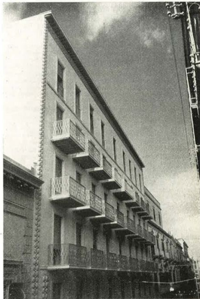
TRAPANI - La facciata principale del nuovo palazzo dell'I.N.A. sulla via Garibaldi, con la serie dei balconi e con i motivi ornamentali ripresi dalla facciata del vecchio palazzo Xirinda, sulla cui area il nuovo palazzo è stato costruito, si riallaccia ai tipici esempi dell'architettura che predomina nelle città italiane del Mezzogiorno.
