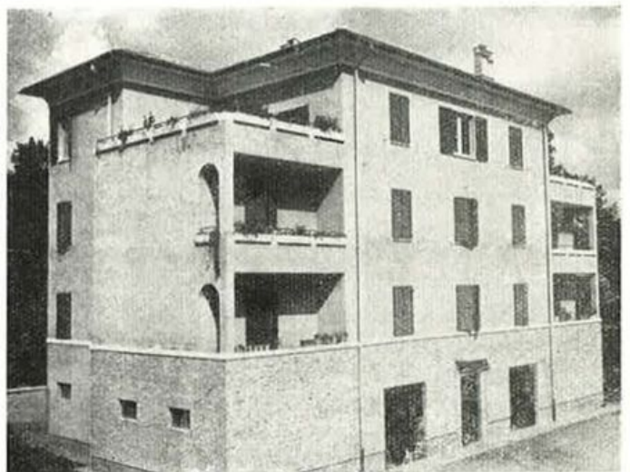
TOLENTINO - Case per i senza tetto costruite con il finanziamento dell'I.N.A.
