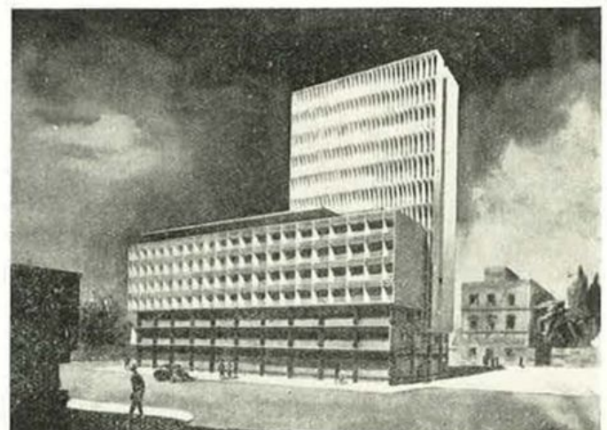
Il centro di distribuzione di piazza Rosolino Pilo a Roma con piezometro per l'alimentazione della rete di distribuzione nel quartiere Gianicolense.
