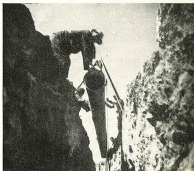
La posa in opera di una tubazione per l'acquedotto del Fiora
