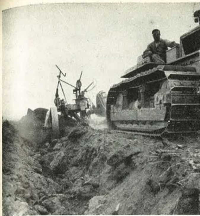
Un trattore al lavoro nella zona bonificata dall'Ente Maremma
