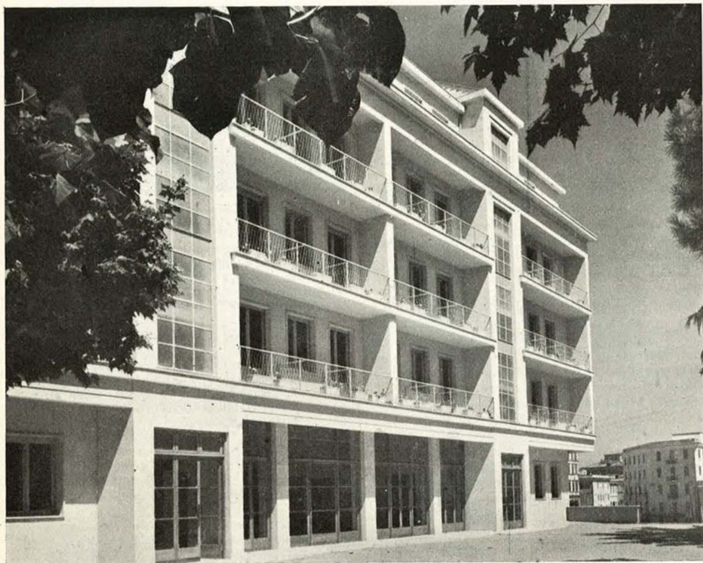
Il lato sud dell'edificio di Frascati.
