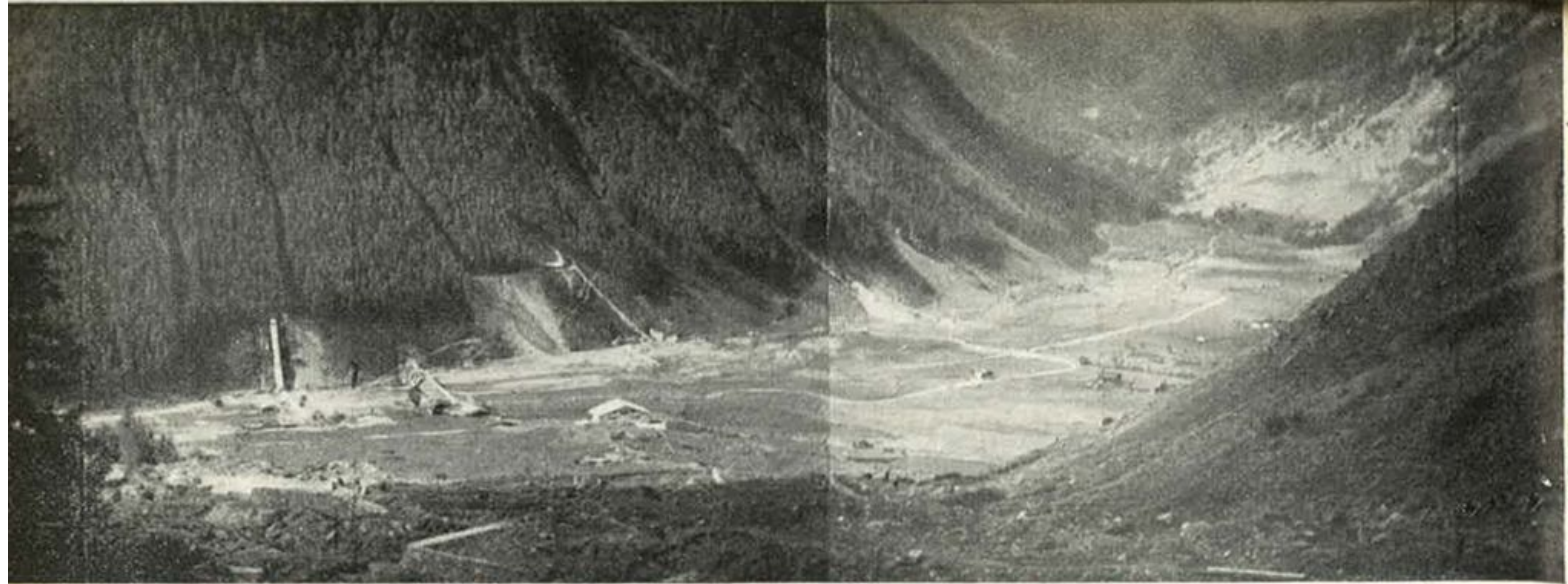
Bacino di Vernago: veduta generale dalla sommità del conoide del Rio Vernago colla diga in corso di esecuzione. (Da sinistra: taglione, avandiga, imbocchi di opere di scarico, pozzo di manovra e casa guardiani).
