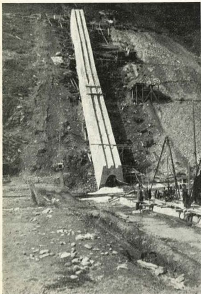
Diga di Vernago - Taglione: cunicolo d'ispezione in sponda destra.
