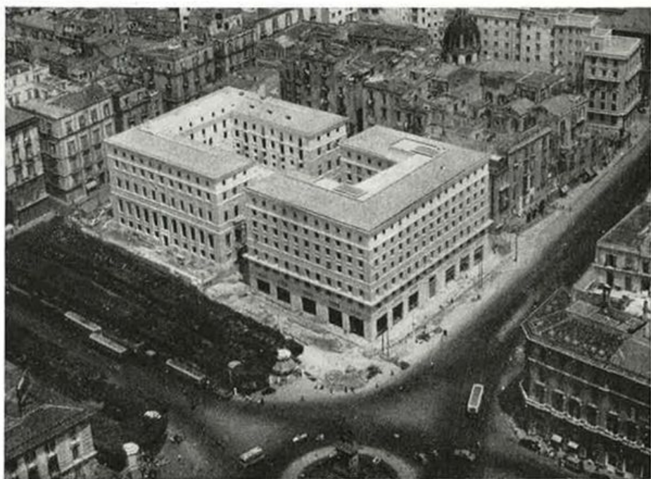
Una veduta aerea del complesso edilizio, costituito a Napoli dall'edificio dell'I.N.A. e da quello della Banca d'Italia.
