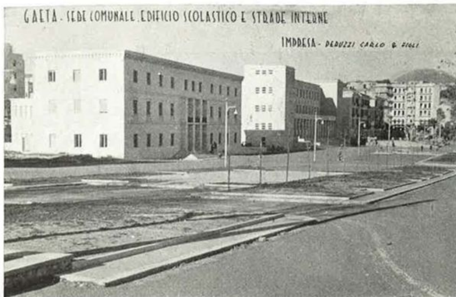
Il palazzo comunale e l'edificio scolastico di Gaeta, costruiti con il concorso finanziario dell'I.N.A.
