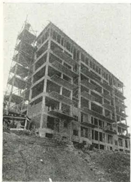
Prospetto del palazzo di Frosinone a lato valle.
