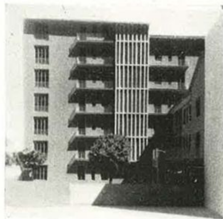
Il palazzo di Arezzo visto dal giardino.
