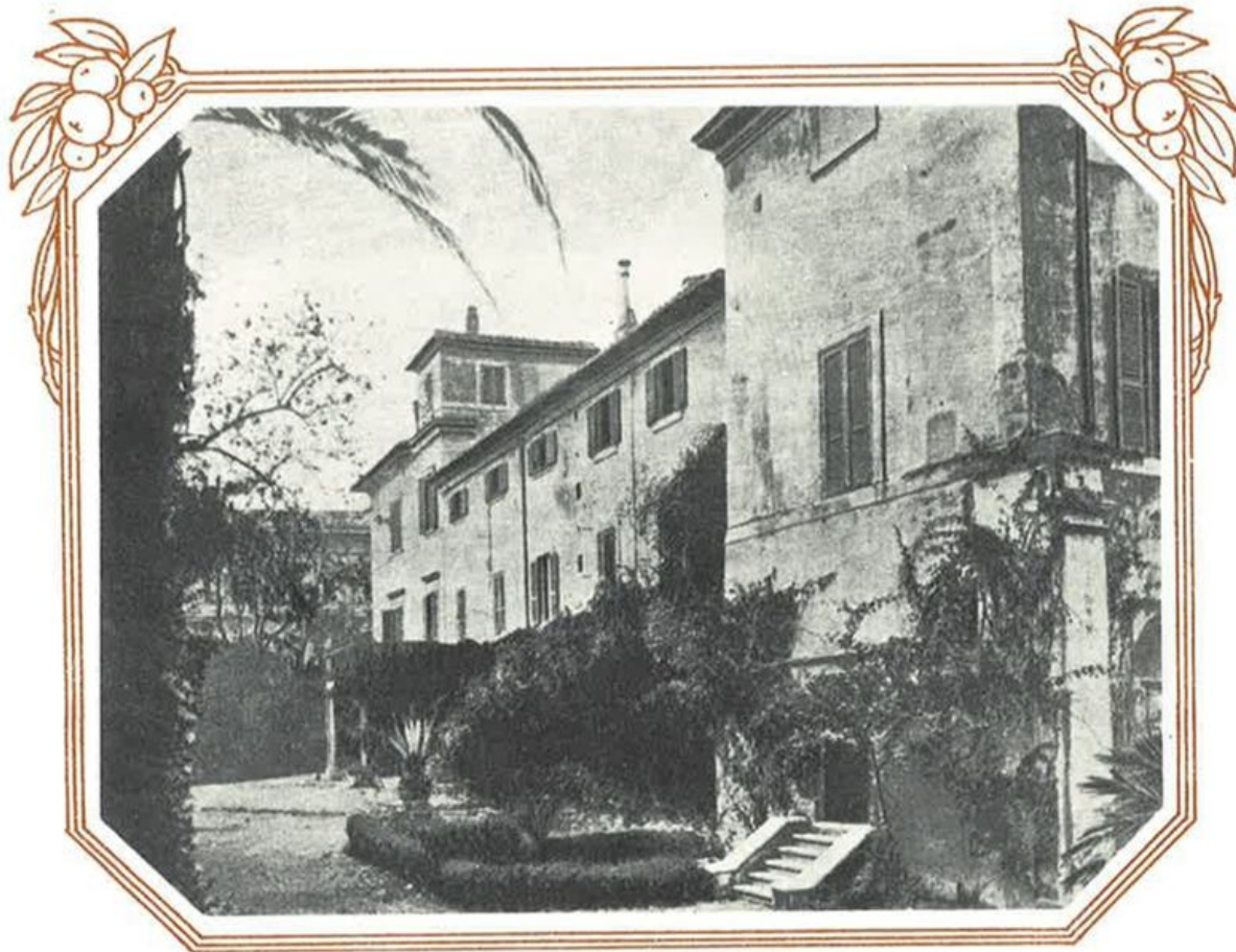
Il palazzo Massimo Colonna che, insieme al grande parco, fu acquistato dall'I.N.A. per costruirvi la sua nuova sede.
