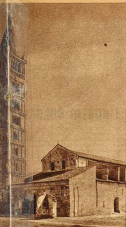
La Chiesa col campanile (Foto Anderson).
