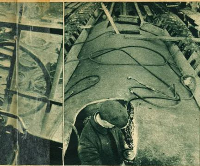
In un sommergibile in costruzione viene praticata l'apertura per il carico dei siluri.
