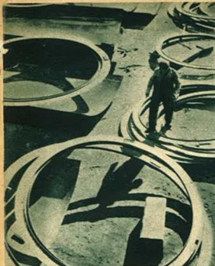
I cerchi di acciaino costituiscono l'armatura del sommergibile.
