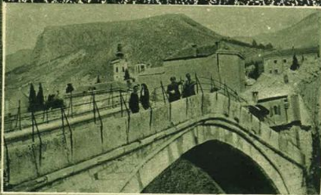
A sinistra: L'arcuato ponte di Mostar sulla Narenta che la tradizione vuole costruito dai Romani.
