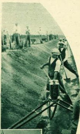
Un'inquadratura durante i lavori di canalizzazione.
